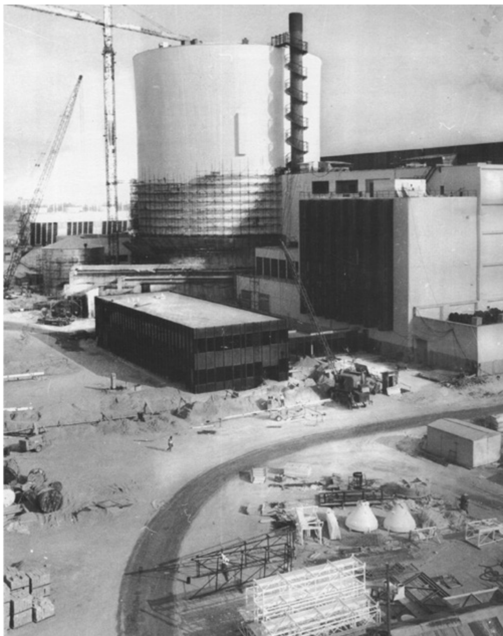
Foto del cantiere della centrale di Caorso
