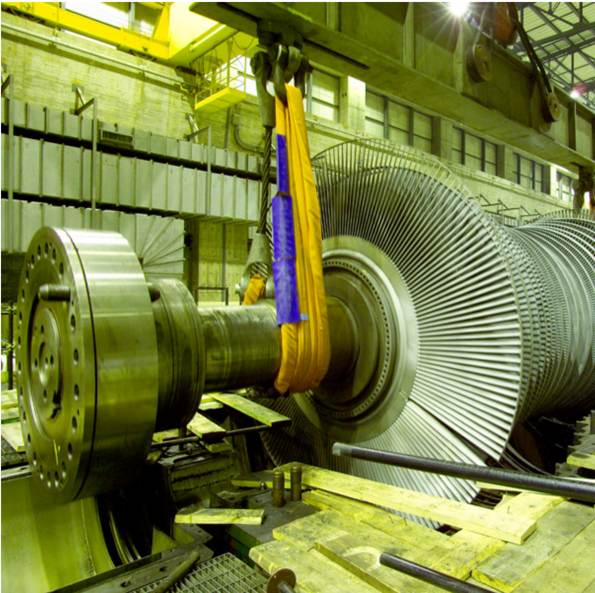
Rimozione della turbina della centrale
