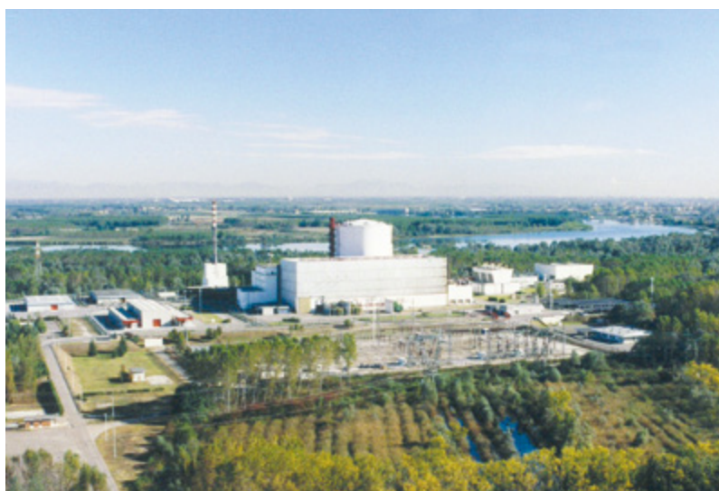
Foto della centrale precedente agli smantellamenti del 2008 (torri di raffreddamento) e del 2010 (edificio off-gas)
