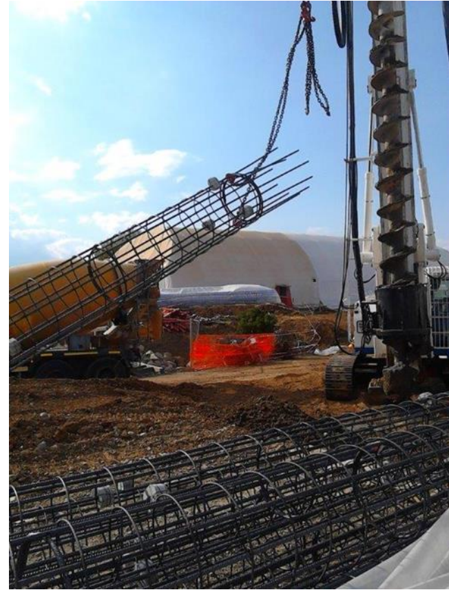
Installazione palificata di sostegno
