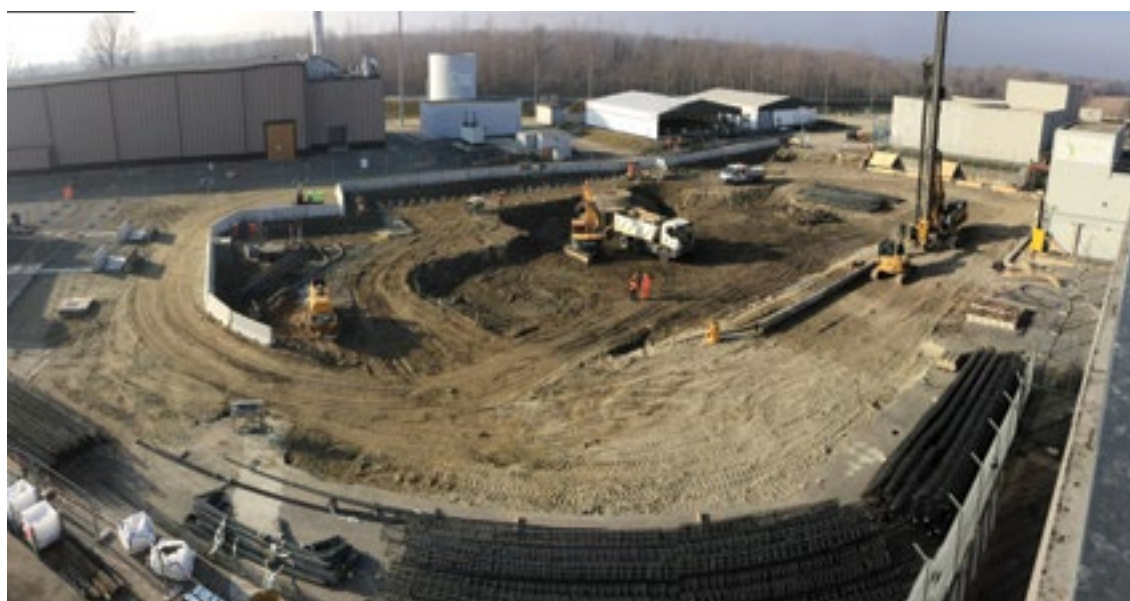
Scavo del cantiere CEMEX
