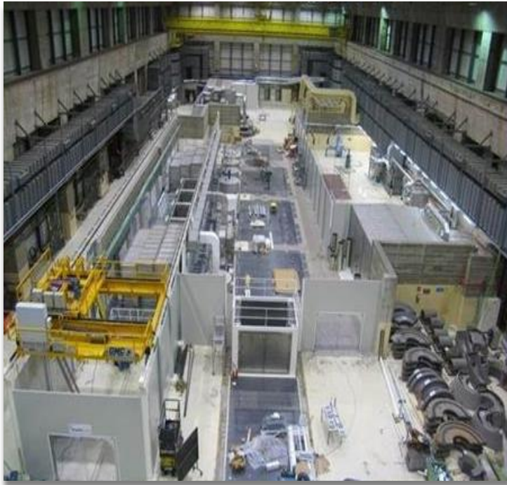
SGM durante le attività di trattamento materiali metallici turbina (2009)
