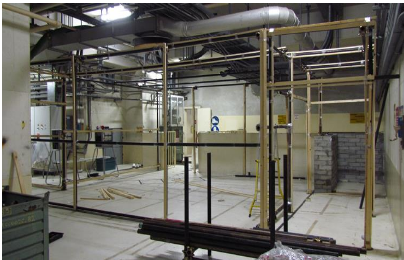
Allestimento della capannina di confinamento
