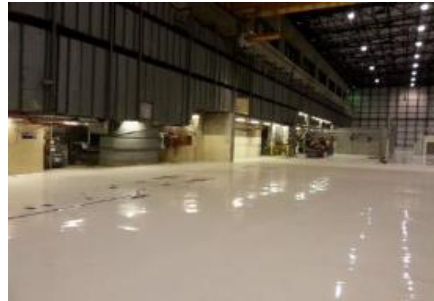
SGM al termine della rimozione carroponete e rifacimento pavimentazione (2015)
