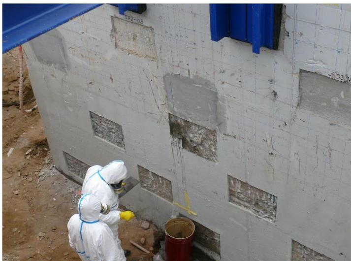
In data 21 Agosto, nel corso della scarifica di alcune finestre dell'intonaco, al fine delle indagini strutturali sul monolite, si è verificato un percolamento di liquido radioattivo proveniente dall'interno del monolite. L'evento non ha determinato alcuna conseguenza radiologica per lavoratori, popolazione e ambiente, ed è stato notificato ad Ispra.
