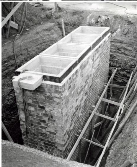
La struttura è costituita da un "monolite" in calcestruzzo interrato per una profondità di 6,2 metri
