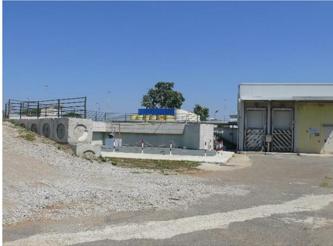
A dicembre 2013 è stato ultimato il capannone che garantisce il confinamento dall'ambiente esterno e sono stati ultimati e collaudati gli impianti di servizio; ovvero impianto ventilazione, impianto sollevamento interno, impianto antincendio, impianto elettrico e monitoraggio radiologico.
