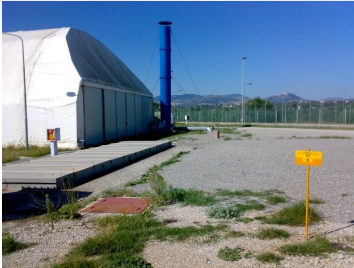
Avanzamento dei lavori di sistemazione rifiuti a luglio 2010
