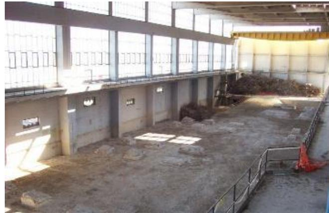
Edificio turbine dopo i lavori di decontaminazione e smantellamento dei componenti metallici.
