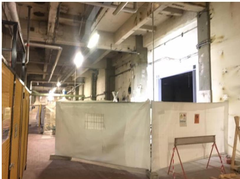
Lavori di ripristino del locale collettore del vapore, propedeutici alla futura realizzazione della stazione di monitoraggio intermedio necessaria per la caratterizzazione dei materiali ai fini del rilascio.
