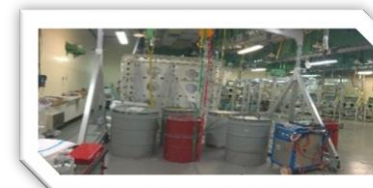
Impianto di Casaccia Opec 2 – adeguamento deposito
