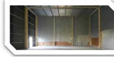
Impianto di Bosco Marengo Locale B106 – opere civili
