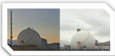
Centrale del Garigliano Demolizione camino
