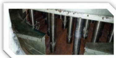
Centrale di Trino Smantellamento tubazioni circuitto secondario
