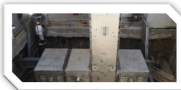
Impianto di Trisaia Bonifica Fossa 7,1
