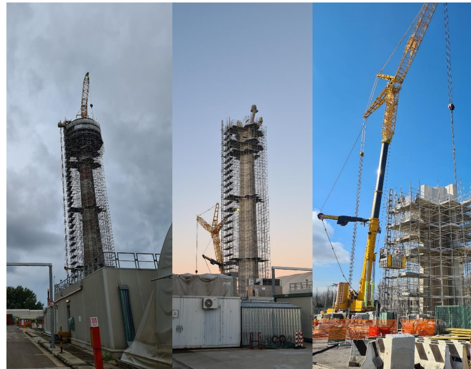
Sequenza smantellamento torre idrica
