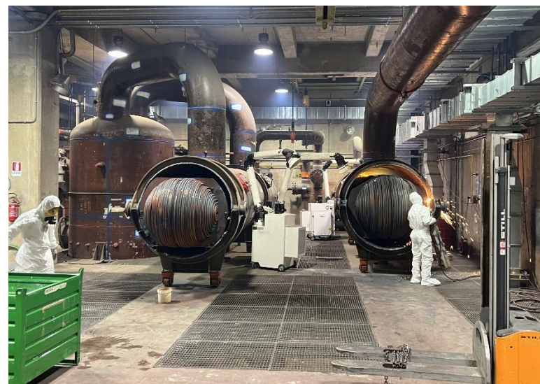
Rimozione Preriscaldatori
