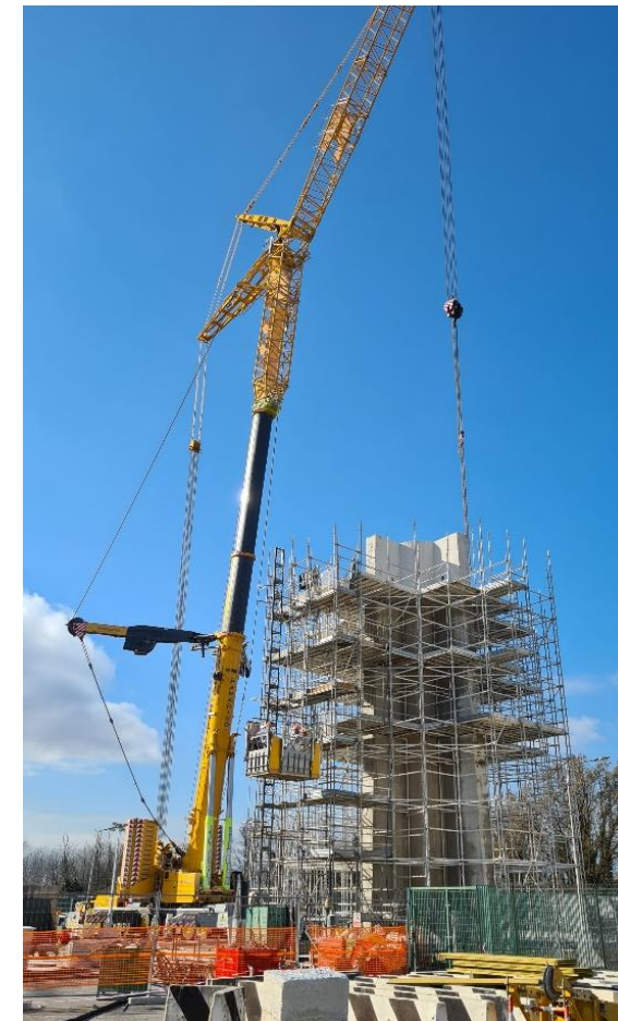
Demolizione Torre idrica
