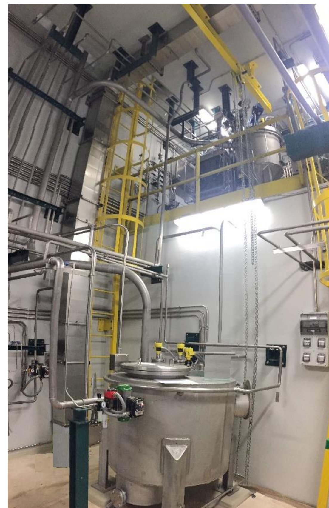
Fig. 2: Serbatoi di processo Edificio Condizionamento
