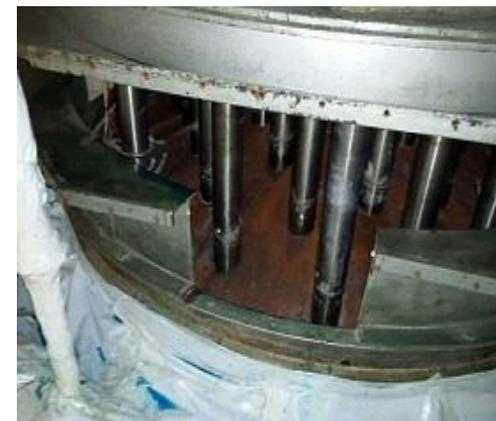
Attività propedeutica alla fase di progettazione dello smantellamento del Vessel. Rimosso l'amianto dalla parte superiore del vessel, eseguita la bonifica dei setti schermanti del Vessel e conclusa la bonifica riguardante i setti contenenti amianto e faesite.
