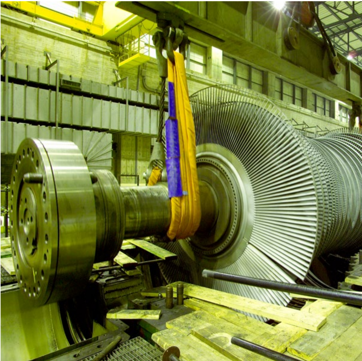
Rimozione della turbina della centrale
