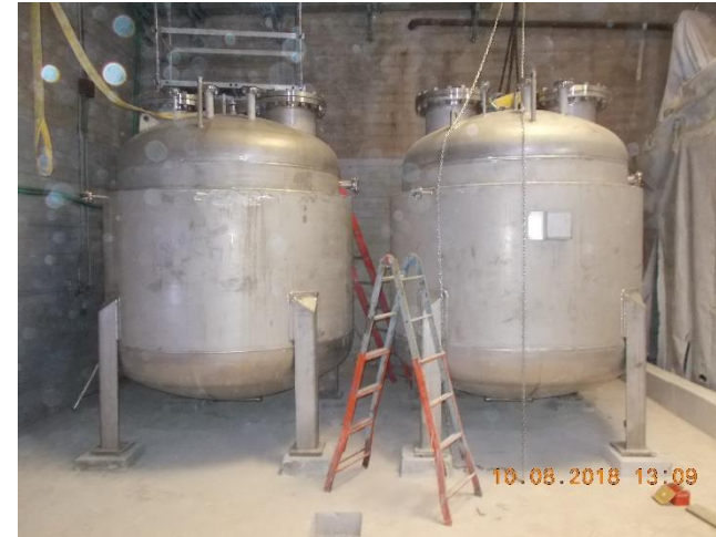
Posa serbatoi di accumulo a Q.ta +3,50.
