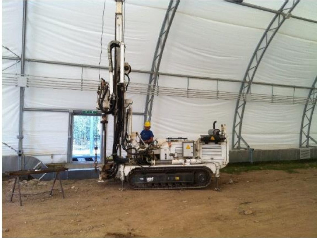
Carotaggi trincea n. 1
