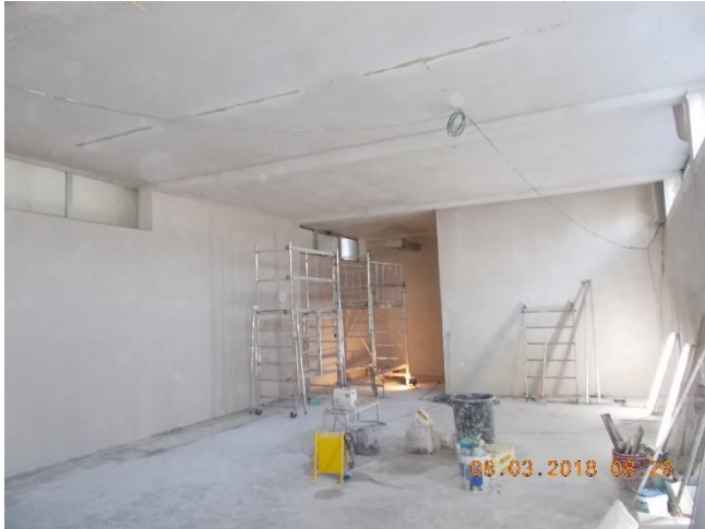
Adeguamento Sala Controllo Edificio RadWaste.
