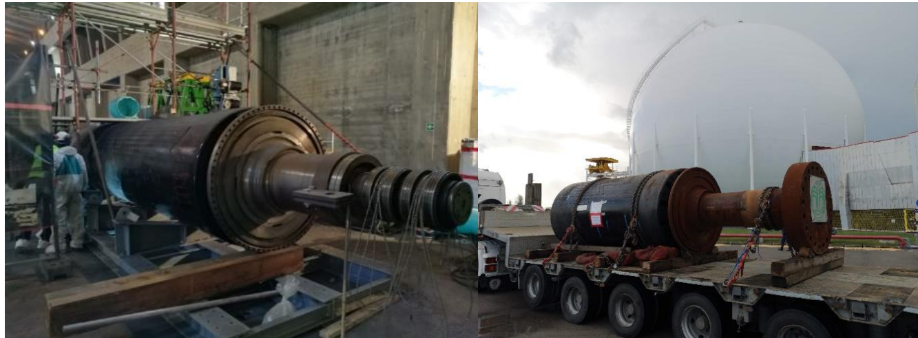
Allontanamento dell'alternatore
