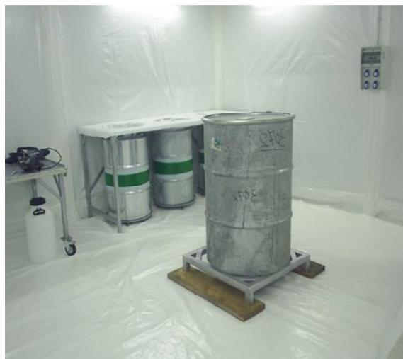
E' stato completato il riconfezionamento di n.712 fusti denominati Matrioske con la supercompattazione dei rifiuti in esse contenuti, l'inserimento in fusti overpack ed il loro rientro in centrale con riduzione del 50% del volume occupato nei depositi.
