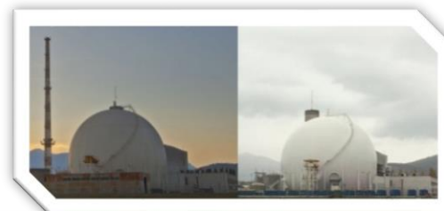
Centrale del Garigliano Demolizione camino
