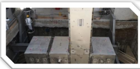
Impianto di Rotondella Bonifica Fossa 7,1
