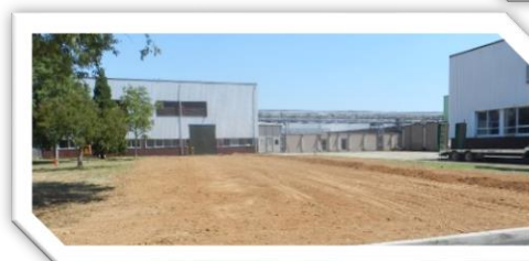
Impianto FN di Bosco Marengo Demolizione Building 10
