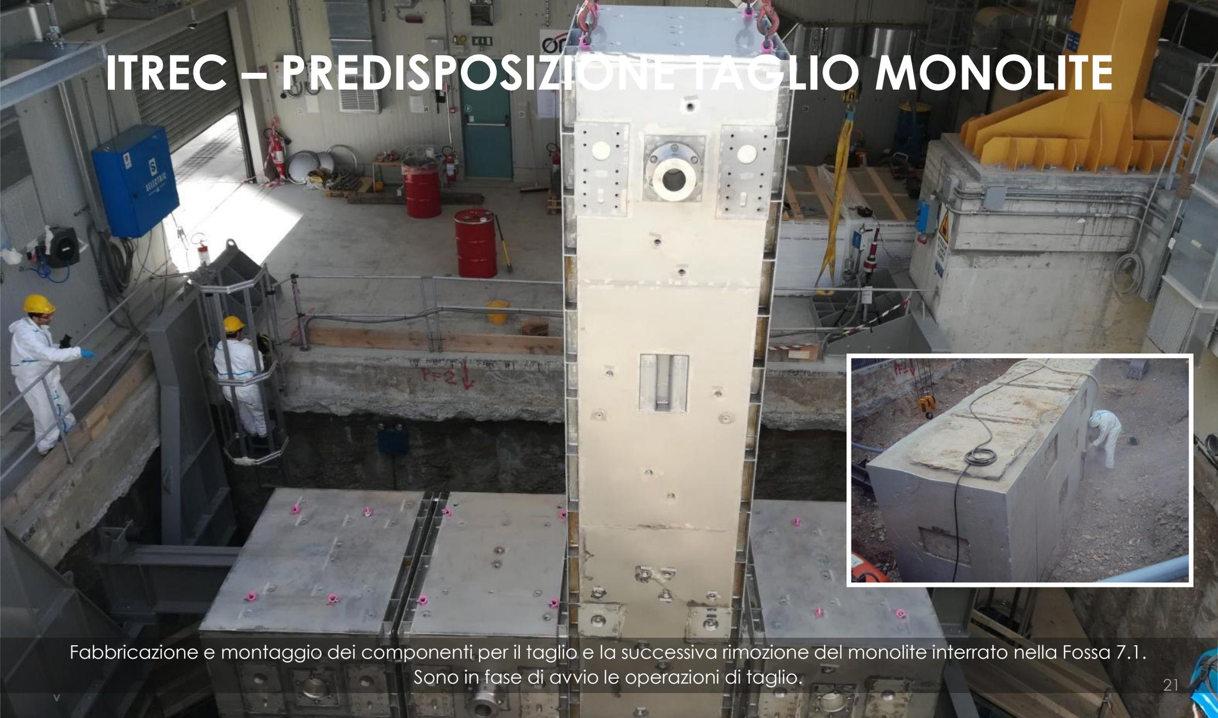
Fabbricazione e montaggio dei componenti per il taglio e la successiva rimozione del monolite interrato nella Fossa 7.1.
