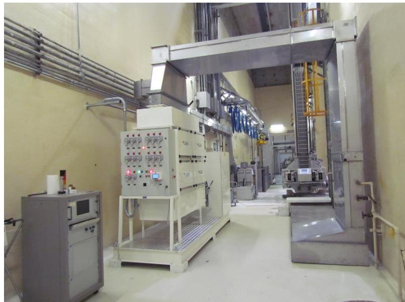
Sono state concluse nel primo semestre 2017 le attività di modifica delle attrezzature esistenti e l'installazione di nuove attrezzature e strumentazione (sistema di infustamento in overpack, gamma scanner per la caratterizzazione fusti, sistema di ventilazione, strutture di confinamento e di accesso). Le modifiche sono finalizzate alla predisposizione al trasporto dei fusti estratti dalle celle schermate
