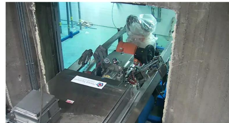
Fase di estrazione del robot di scarifica
