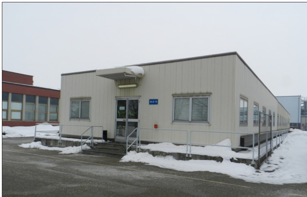
Figura 3 - Vista frontale Edificio BLD10
