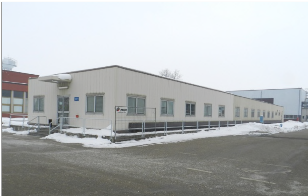
Figura 2 - Vista laterale Edificio BLD10
