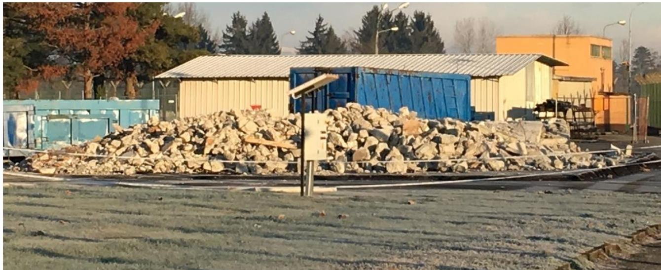
Nella baia di deferrizzazione si effettua la suddivisione del cemento armato in cemento e armatura di ferro
