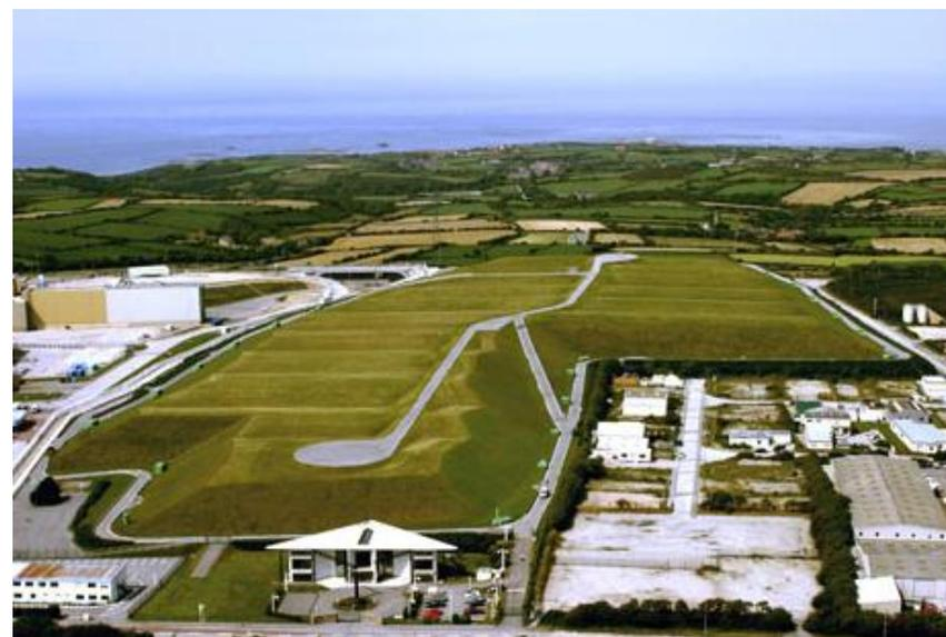
Deposito di superficie per circa 500.000 mc di rifiuti radioattivi a bassa e media attività, provenienti da attività nucleari, di ricerca, medicina ed industria. Entrato in esercizio nel 1969 e completato nel 2004, il deposito è sotto controllo istituzionale dal 2003.
