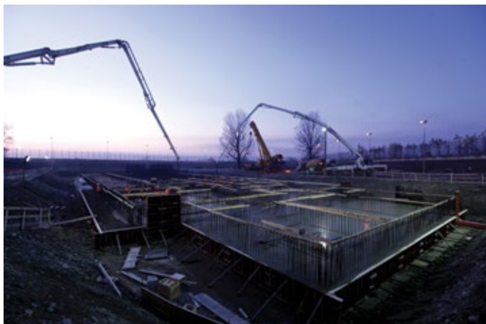
Costruzione del deposito D2 - Impianto EUREX di Saluggia
