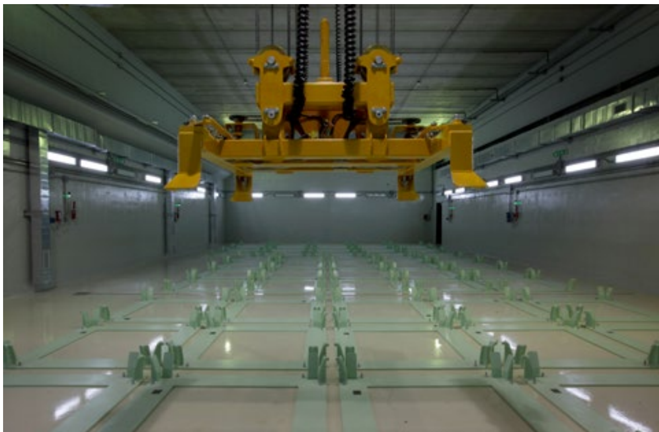
Deposito temporaneo D1 - Centrale di Latina
