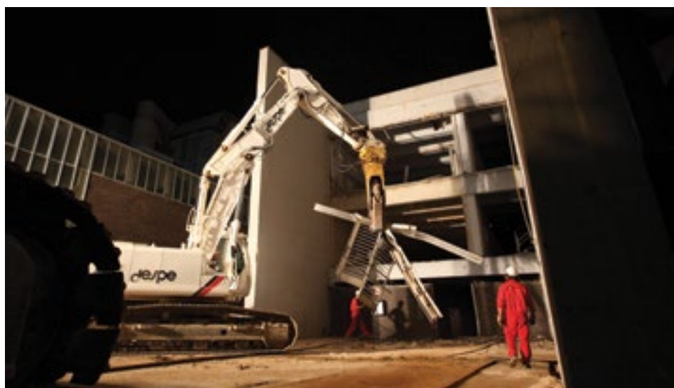
Demolizione dell’Edificio Turbine - Centrale di Latina
