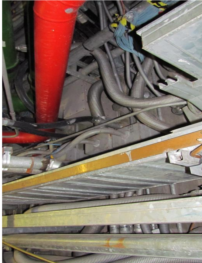
Figura 6-4: Penetrazione 774, di difficile accessibilità causa l'interferenza di componenti d'impianto
