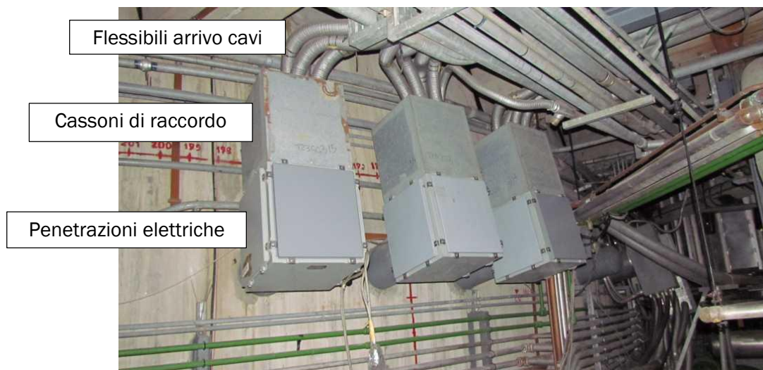
Figura 6-9: Penetrazioni elettriche del contenitore primario
