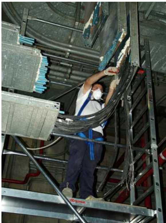
Figura 6-2: Esempi di sezionamento di canale porta-cavi e conduit eseguiti in Edificio Turbina
