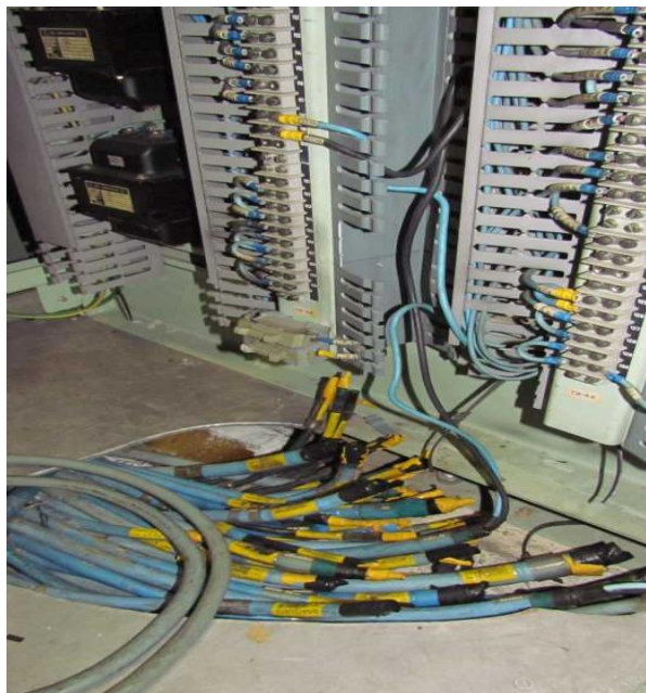
Figura 6-1: Esempio di passivazioni cavi eseguite in un quadro di Sala Manovra
