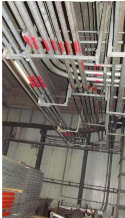
Figura 6-10: Esempio di identificazione vie cavo
