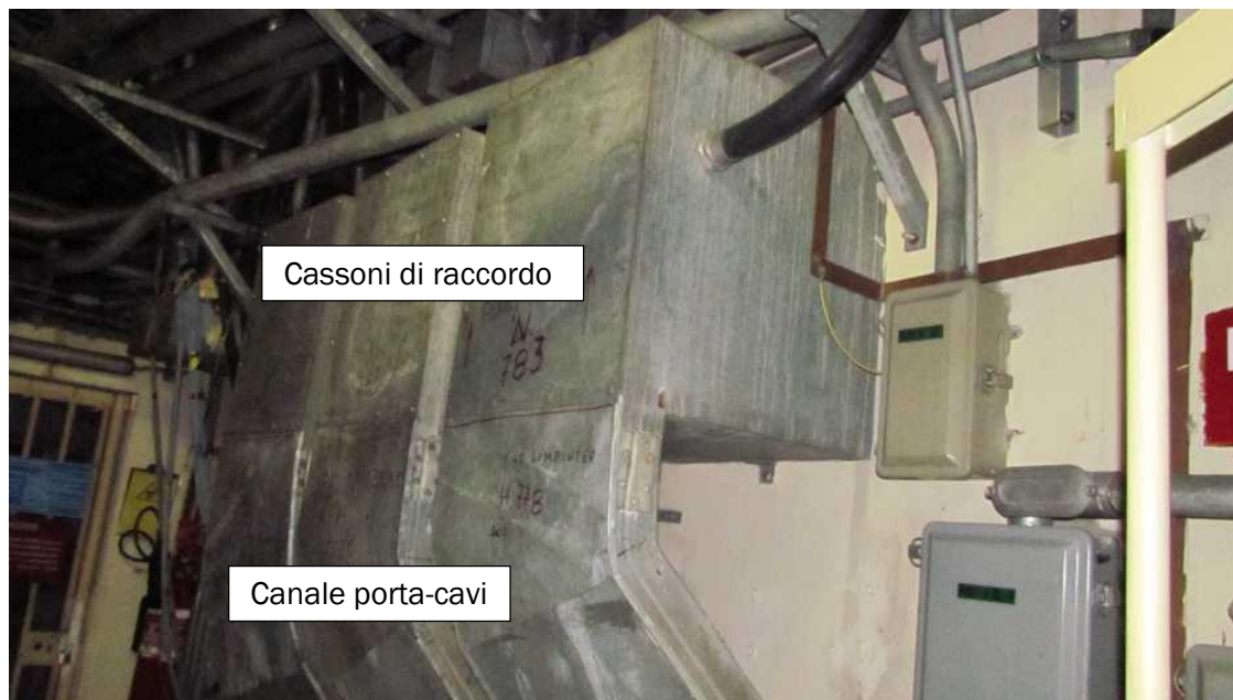
Figura 6-6: Penetrazione 778, con i cassoni di raccordo tra tubi di penetrazione (non visibili) e canale
