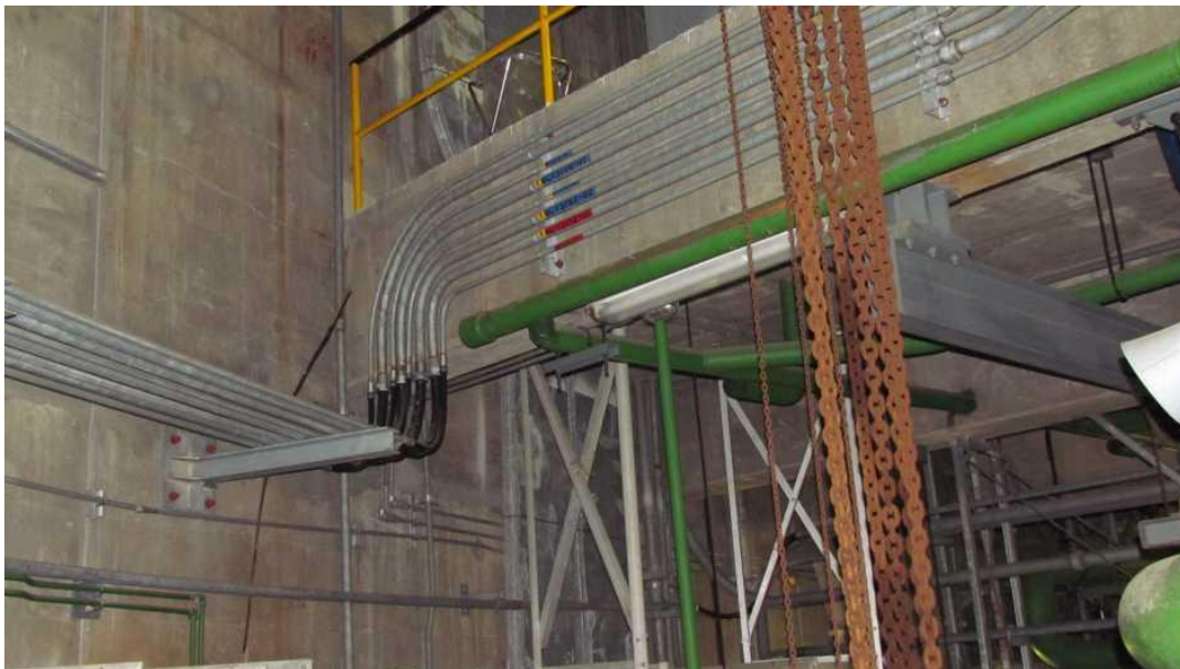
Figura 6-8: Esempio di attraversamenti conduit che non intralciano i passaggi
