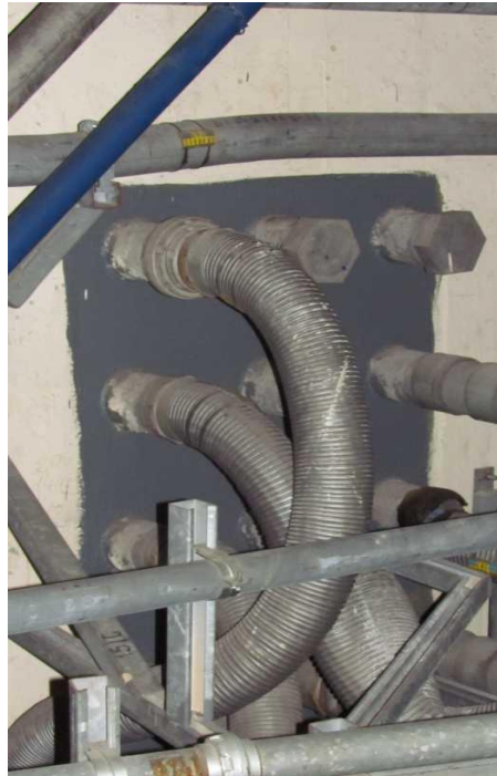
Figura 6-3: Parte superiore della penetrazione 784, composta da 21 tubi (matrice 3x7), tutti connessi a conduit.
