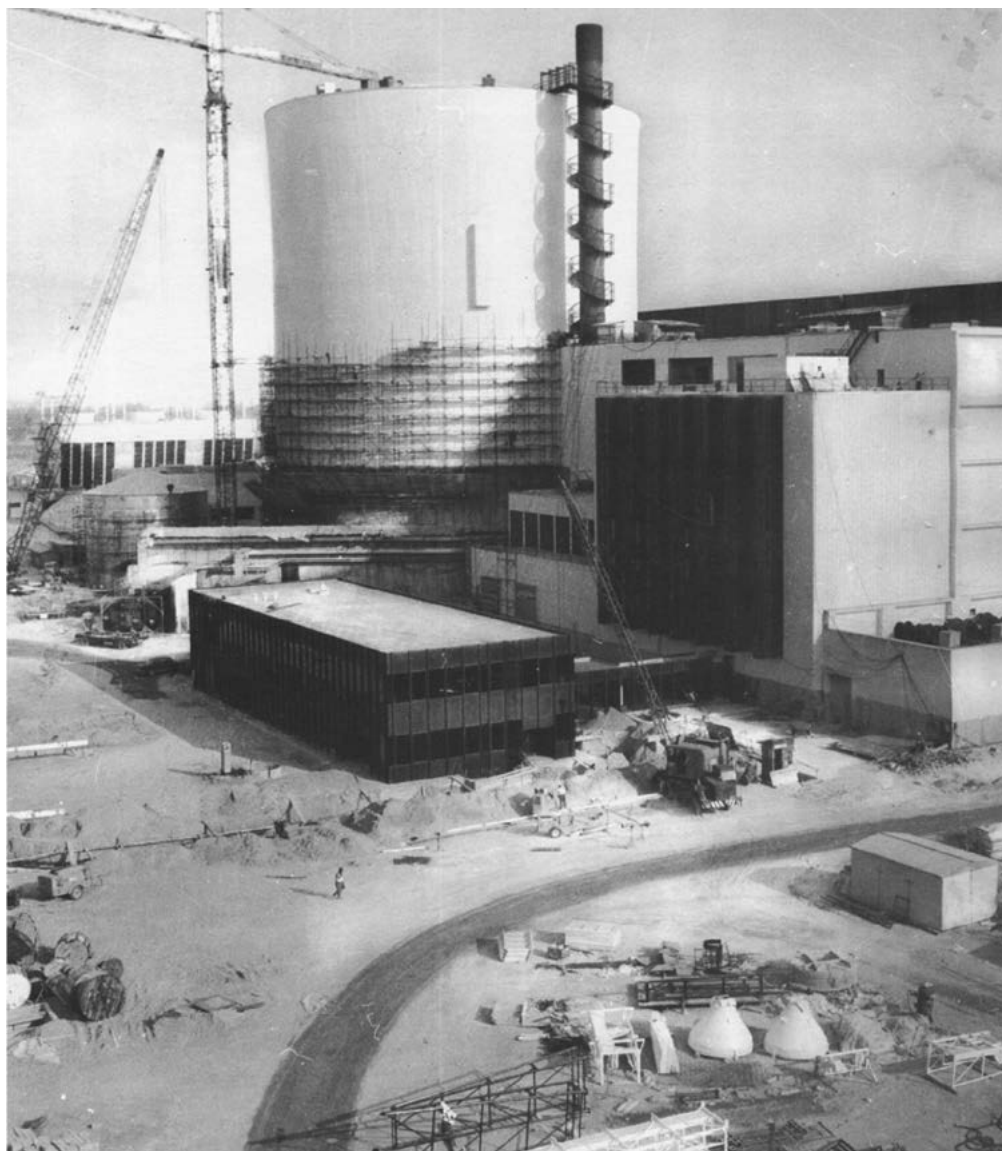
Foto del cantiere della centrale di Caorso
