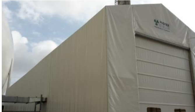
Struttura di confinamento statico e dinamico per realizzazione nuovo Radwaste
