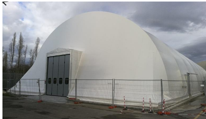
Struttura di confinamento Trincea n. 1
