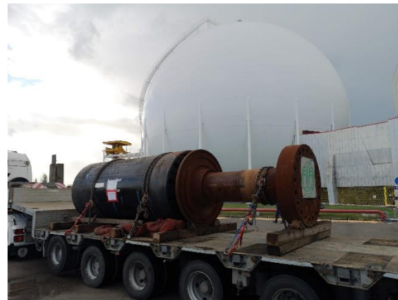
Allontanamento dell'alternatore
