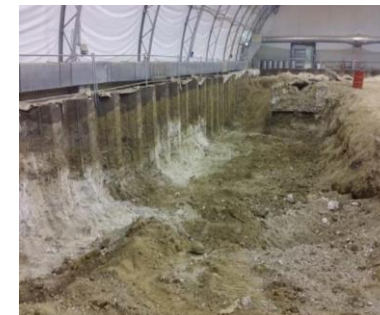
Lavori di bonifica trincea 2 e 3
