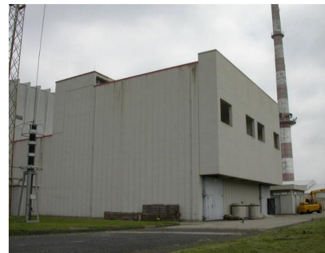
Edificio Ex diesel
