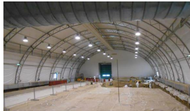
Capannone trincee 2 e 3
