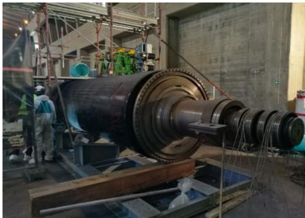
Allontanamento dell'alternatore
