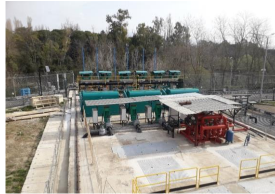
Ripristino Opera di Presa
