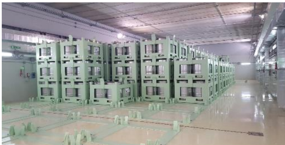
Deposito temporaneo D1
