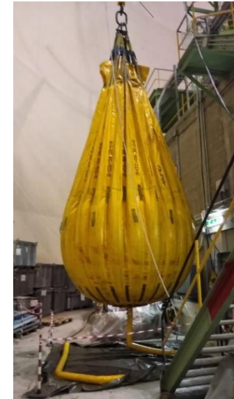
Ripristino sistemi ausiliari nell'edificio Reattore
