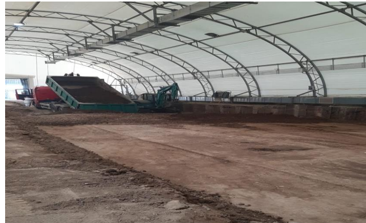
Servizio di bonifica Trincea 1 e supercompattazione rifiuti radioattivi della Centrale del Garigliano
