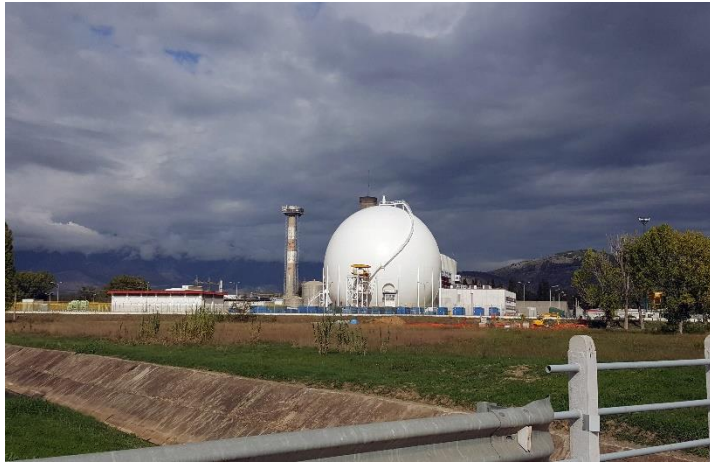
Il vecchio camino in fase di demolizione
