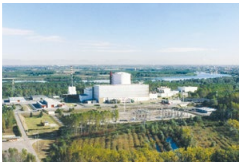
Foto della centrale precedente agli smantellamenti del 2008 (torri di raffreddamento) e del 2010 (edificio off-gas)
