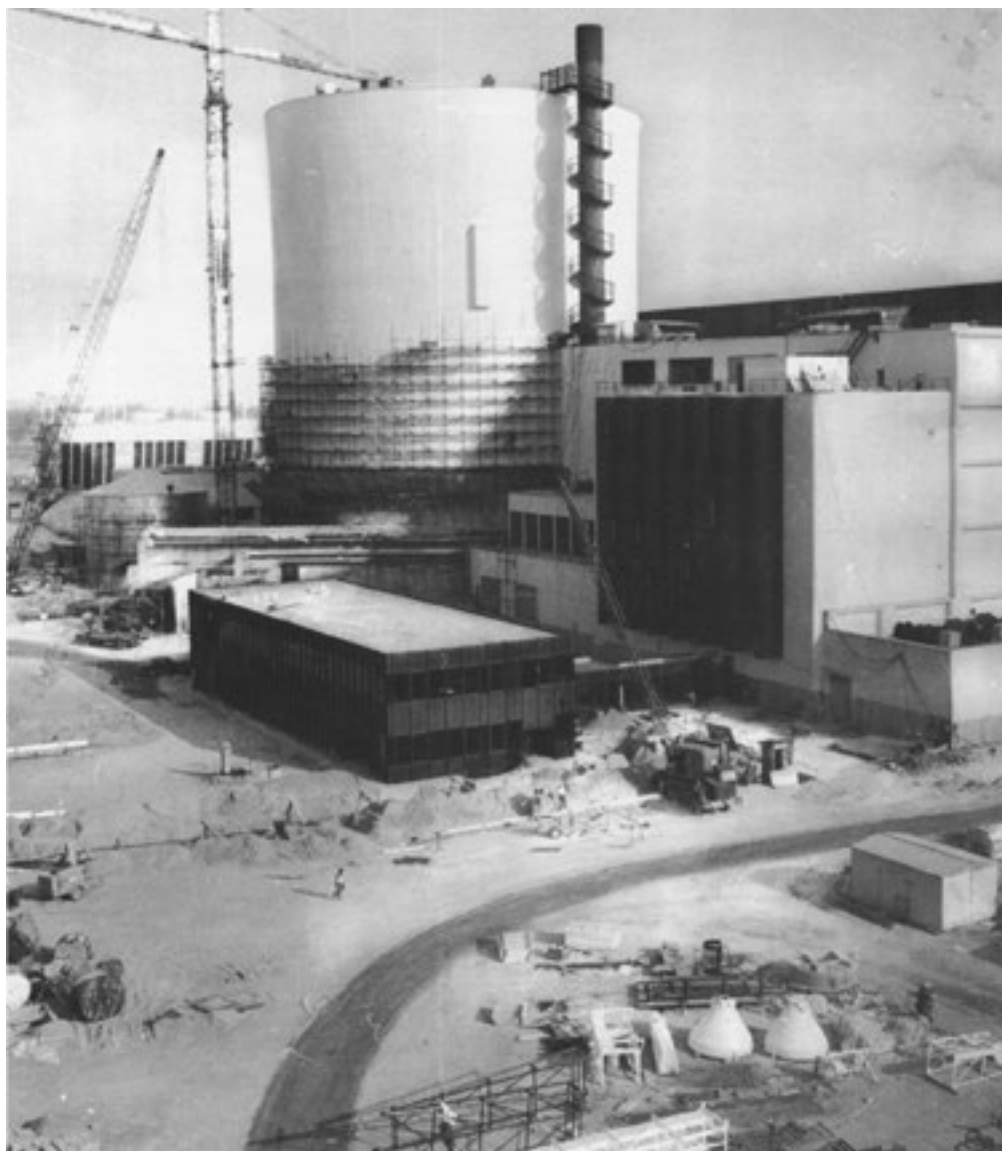
Foto del cantiere della centrale di Caorso
