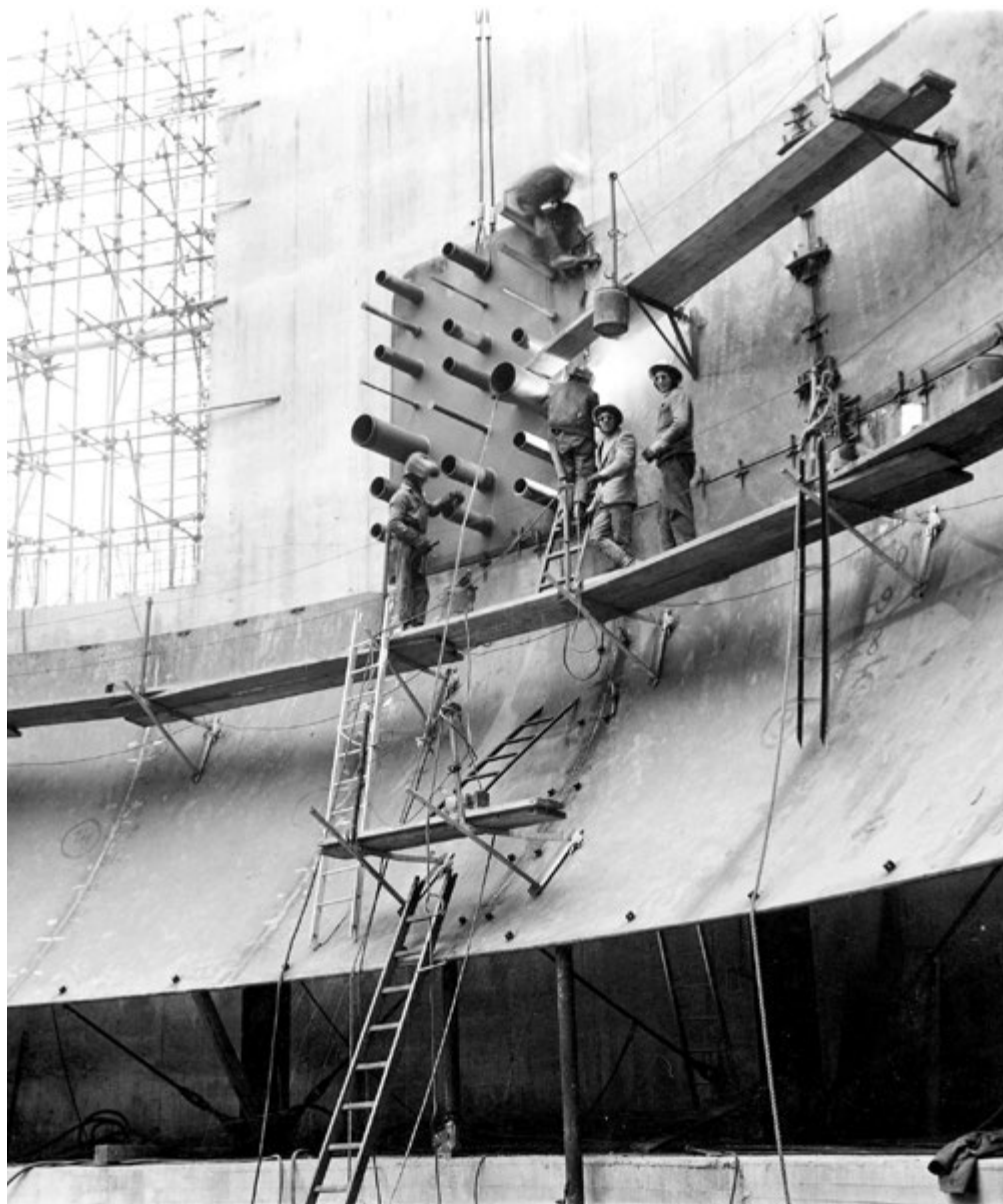
Foto del cantiere della centrale di Trino
