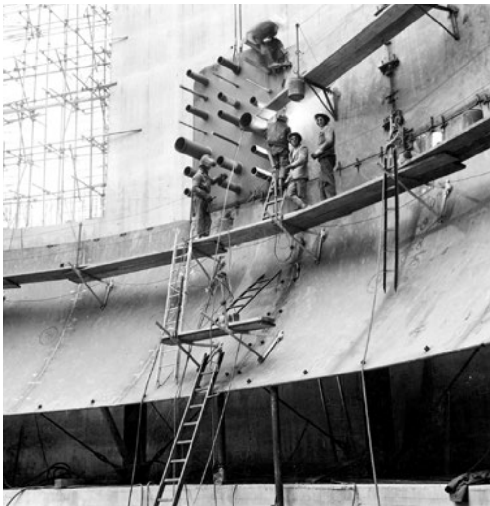
Foto del cantiere della centrale di Trino
