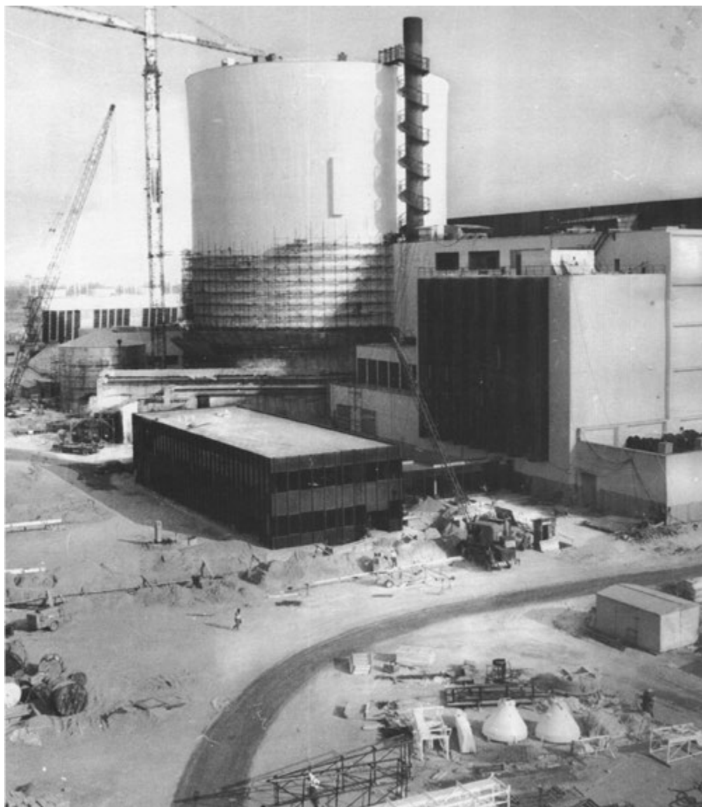
Foto del cantiere della centrale di Caorso
