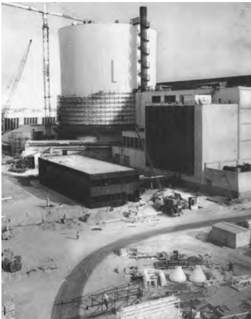
Fase del cantiere della Centrale di Caorso
