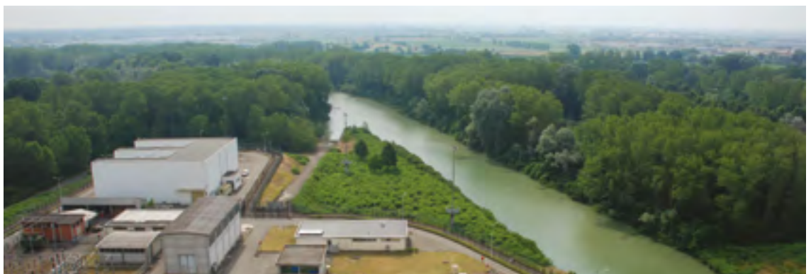
Vista del canale di scarico punto C3
