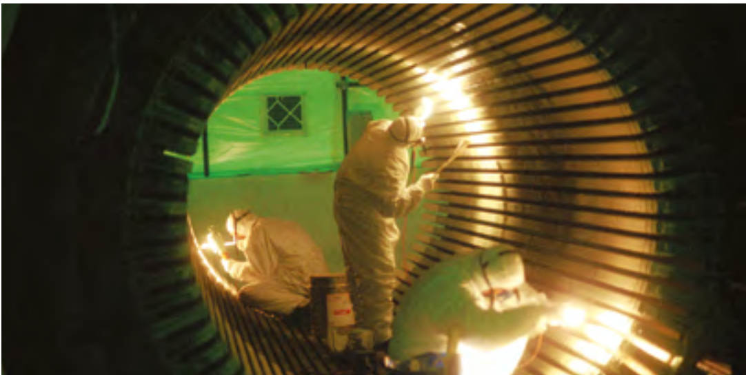
Fasi della rimozione di amianto dallo statore dell'alternatore principale
